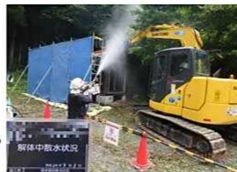
被災家屋等の解体の様子
