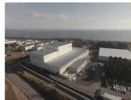
大熊町の仮設焼却施設
