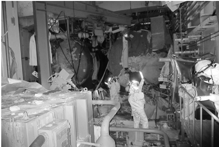
図2-1 福島第一原子力発電所1号機原子炉建屋4階
