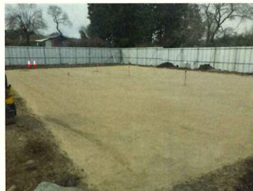
④覆土施工後
