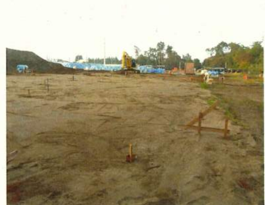
④覆土施工後
