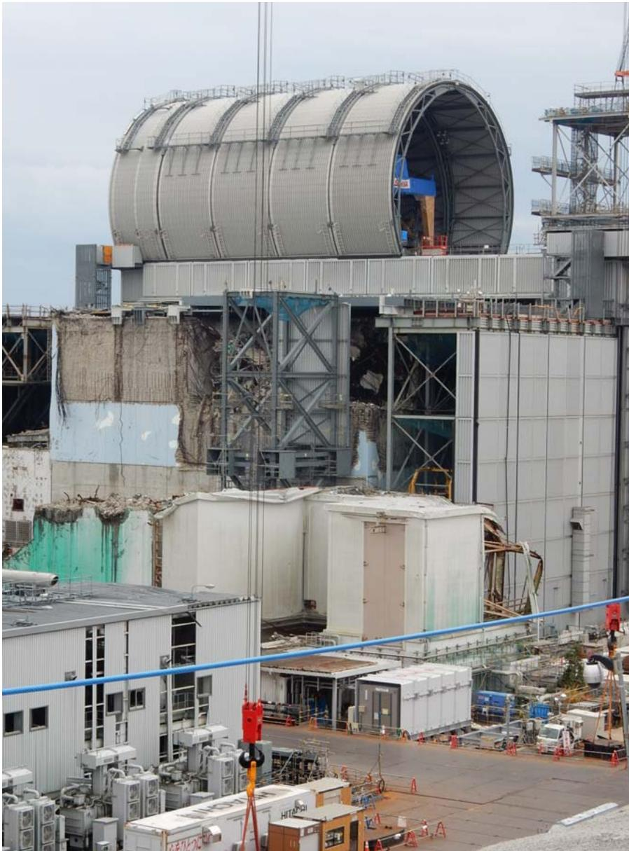
高台から見る3号機。上にみえるドーム状のものは、3号機の使用済み核燃料プールから使用済み核燃料を取り出すために設置されたクレーン等が入っている。
