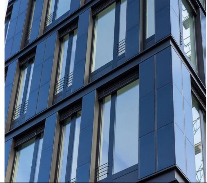
ビルの屋上にPVを置くのが普通だが壁面(ファサード)に設置する例が始まっている。CIGS薄膜のPVが使われている。BIPV(Building Integrated PV)と呼んでいる。3階建て以上のビルでは、屋上に設置するより多くのPVパネルを設置できる。特徴としては、正午ではなく、午前と午後に発電量が大きくなるので、屋上のPVと組み合わせれば出力を平均化できる。冬には雪の照り返しや、低い高度の太陽光を捕えることができる。シュツットガルト大学で開発中。
