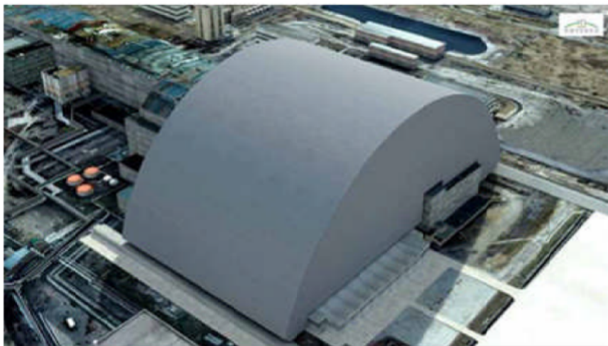
図2. 建設中の第二シェルター（全体が旧シェルター上に移動）
