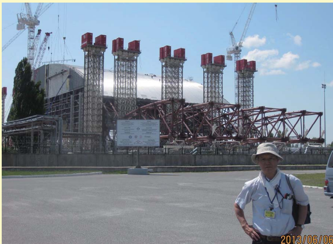
2013年6月 新シェルター建設現場 材料はステンレスで、耐用年数100年の設計だそうです 37
