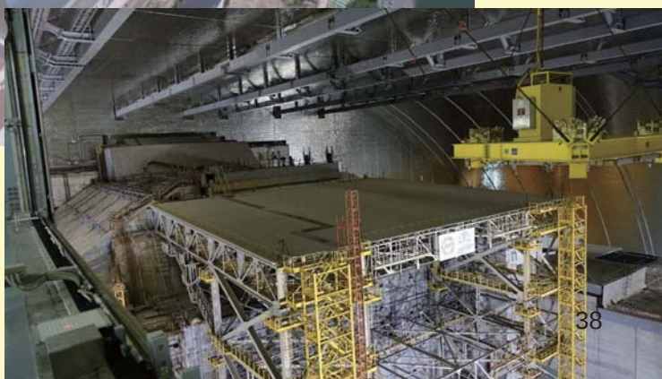
新シェルター内部
