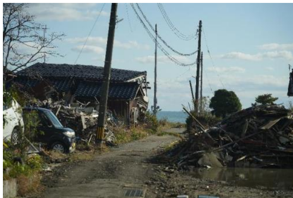
写真上：能登半島地震で倒壊した家屋 (2024 年 11 月撮影)
