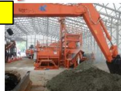
土壌に改質材を混ぜる様子
