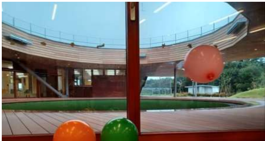
総工費約56億円 大熊町立・学び舎「ゆめの森」
