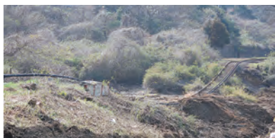
東北地方太平洋沖地震後の液状化現象による道床流失で被害を受けたひたちなか海浜鉄道湊線／茨城県ひたちなか市（2011年4月10日／ウィキメディア・コモンズより転載）
